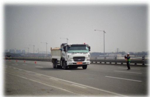
교량 정밀안전진단 현황 (재하시험)
