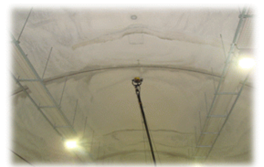
터널 정밀안전진단 현황 (G.P.R 탐사)
