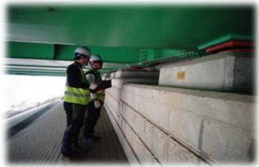
교량 정밀점검 현황 (외관조사)
